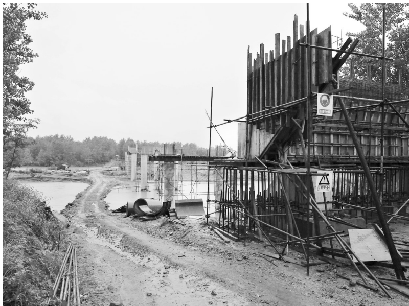
上阳漫水桥改建民生工程
