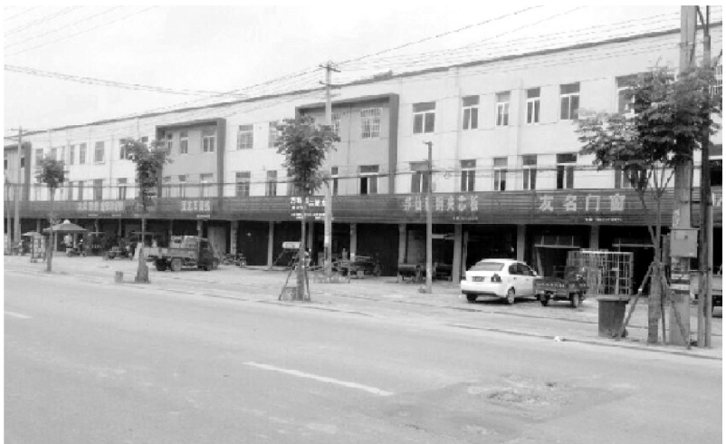
改造后的新杭大道沿街立面。
