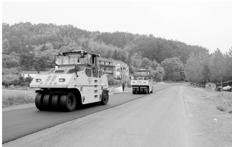
加强小修保养保障公路畅通
