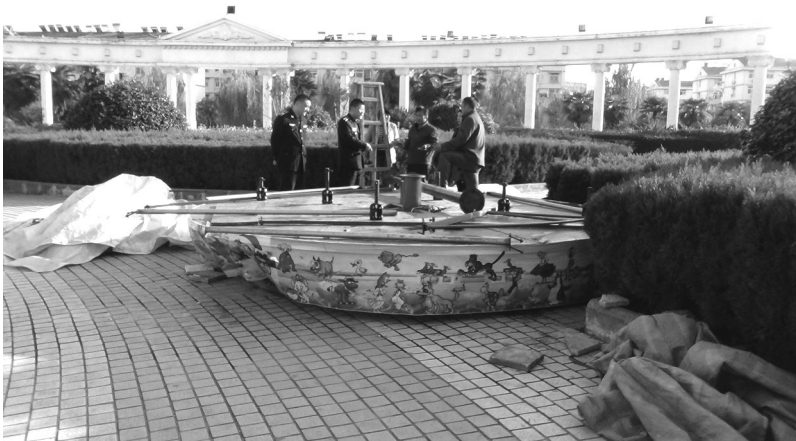
县城管局综合整治期间,组织队员对舒怡广场游乐设施实施拆除。
