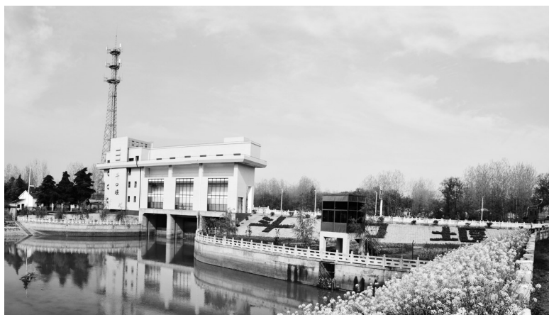
新建后的斗口堰节制闸
