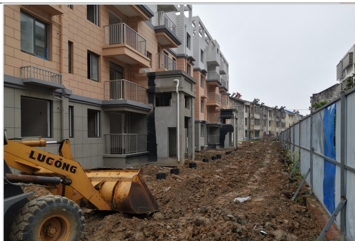
2#住宅楼及场平、道排完成情况
