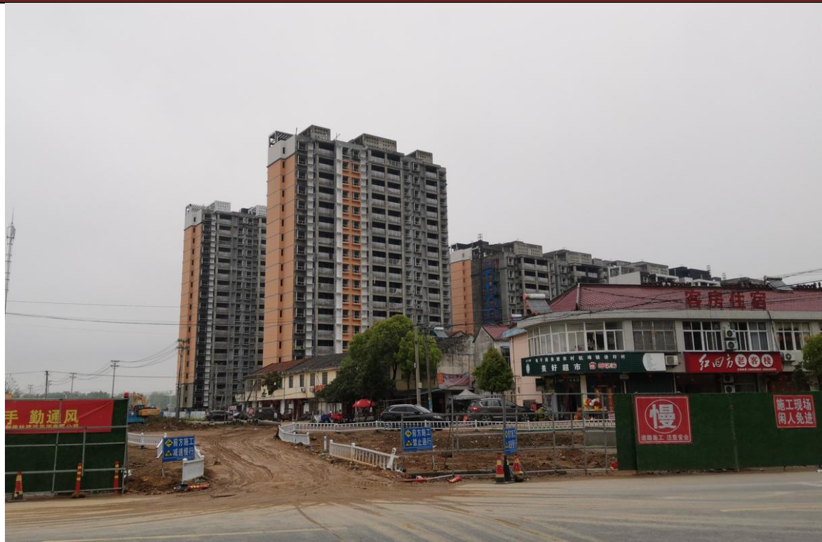
西侧 9#、10#住宅楼完成情况
