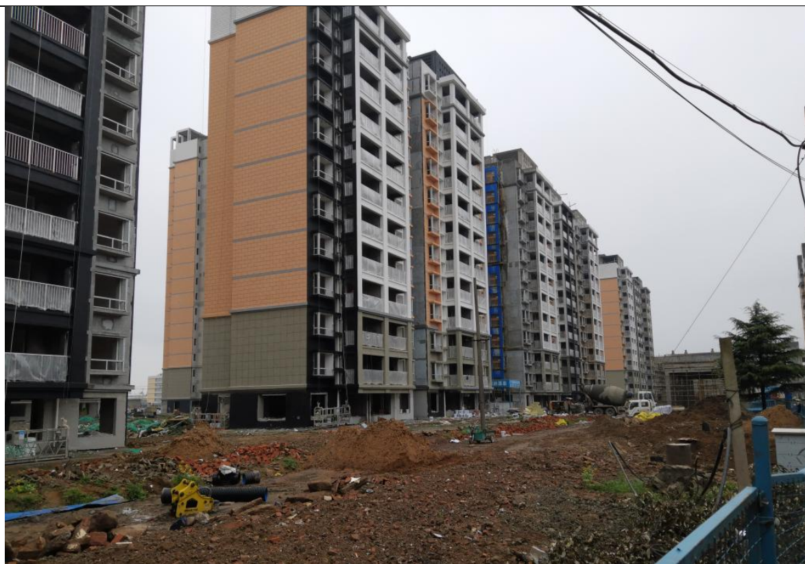
5#、6#、7#住宅楼完成情况
