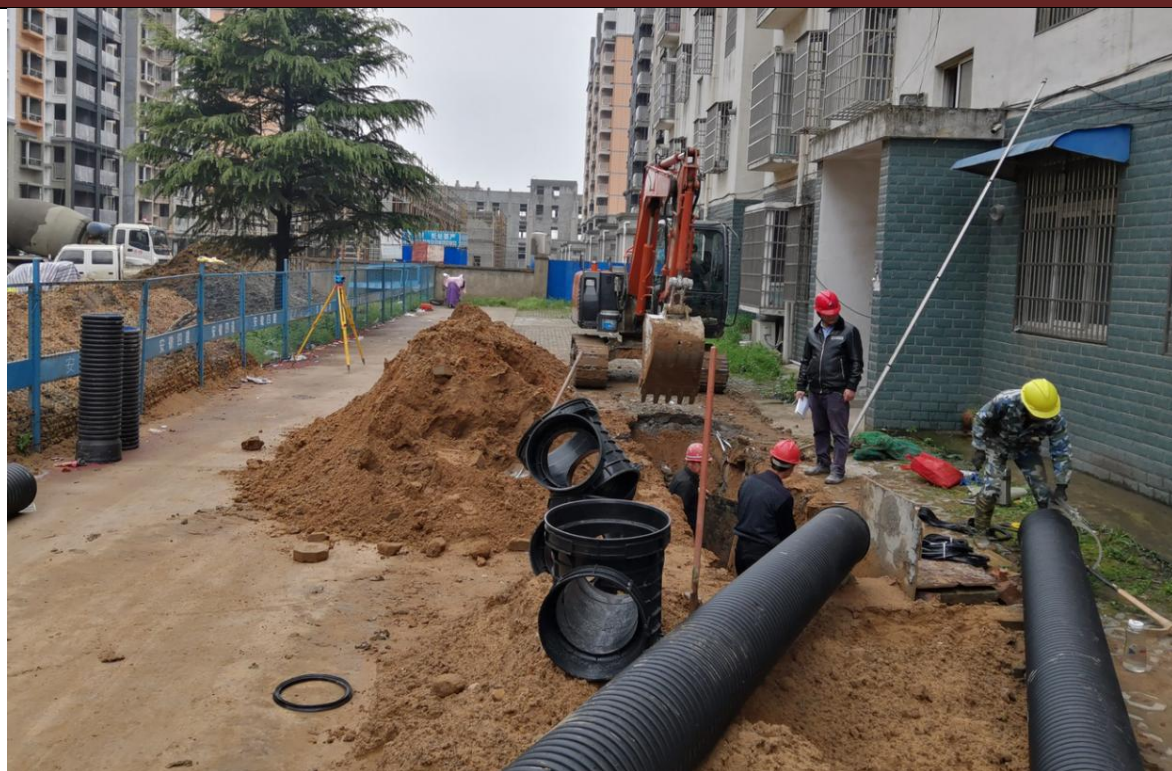
排水管施工情况
