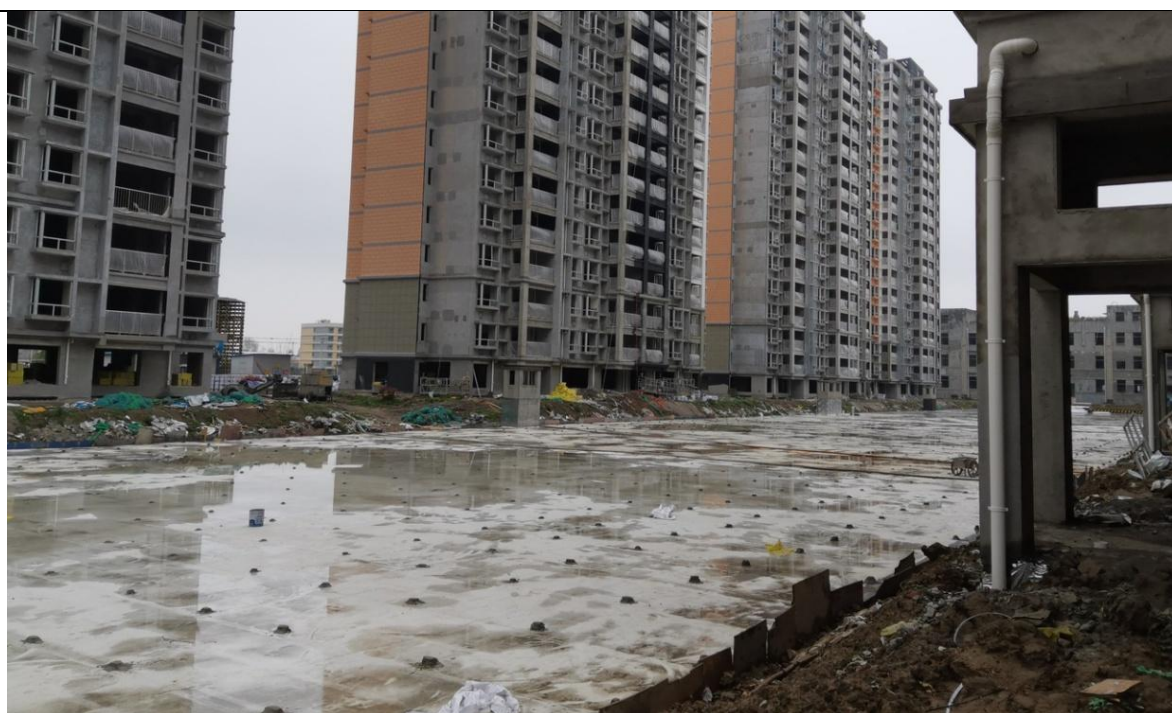
地库顶板施工情况
