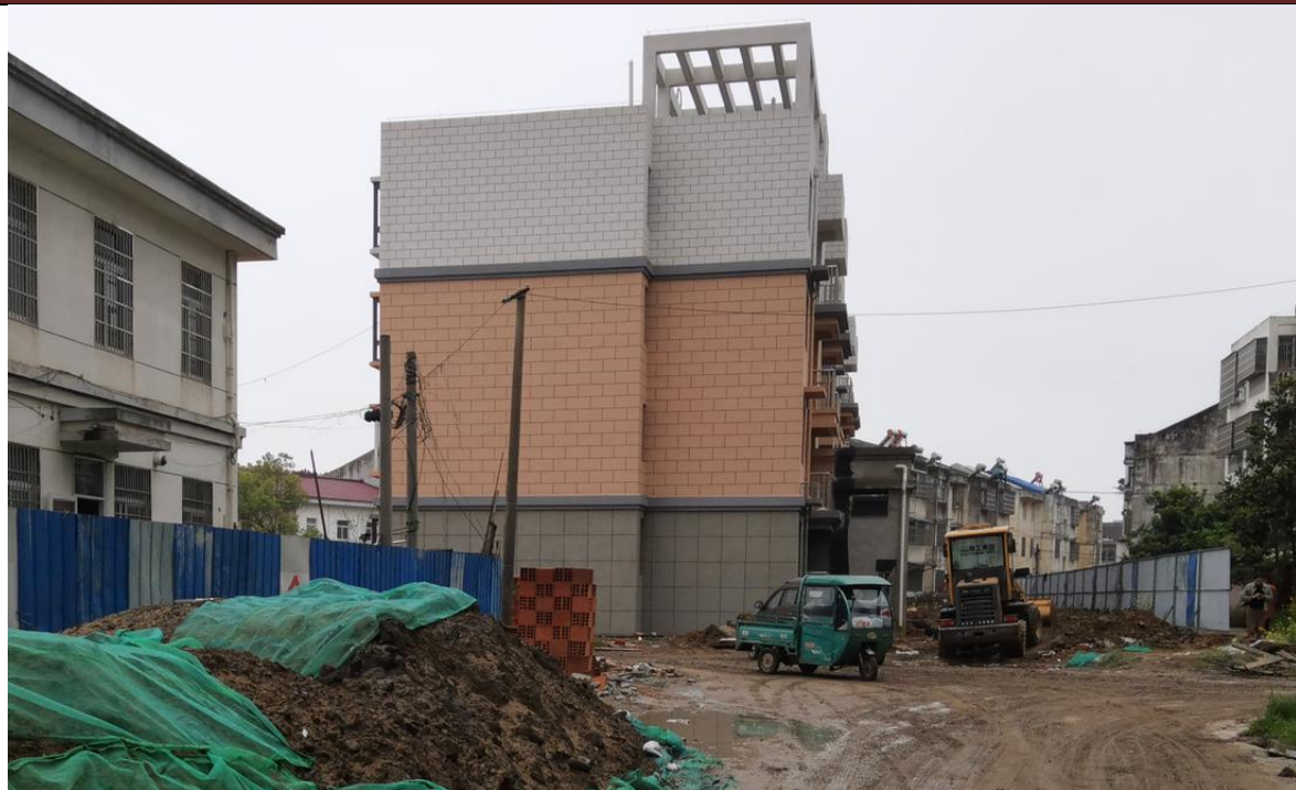
1#住宅楼完成情况
