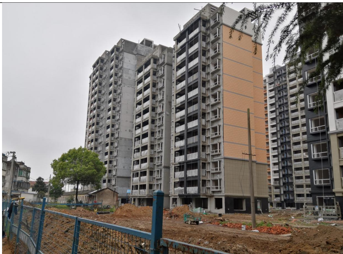
3#、4#住宅楼完成情况
