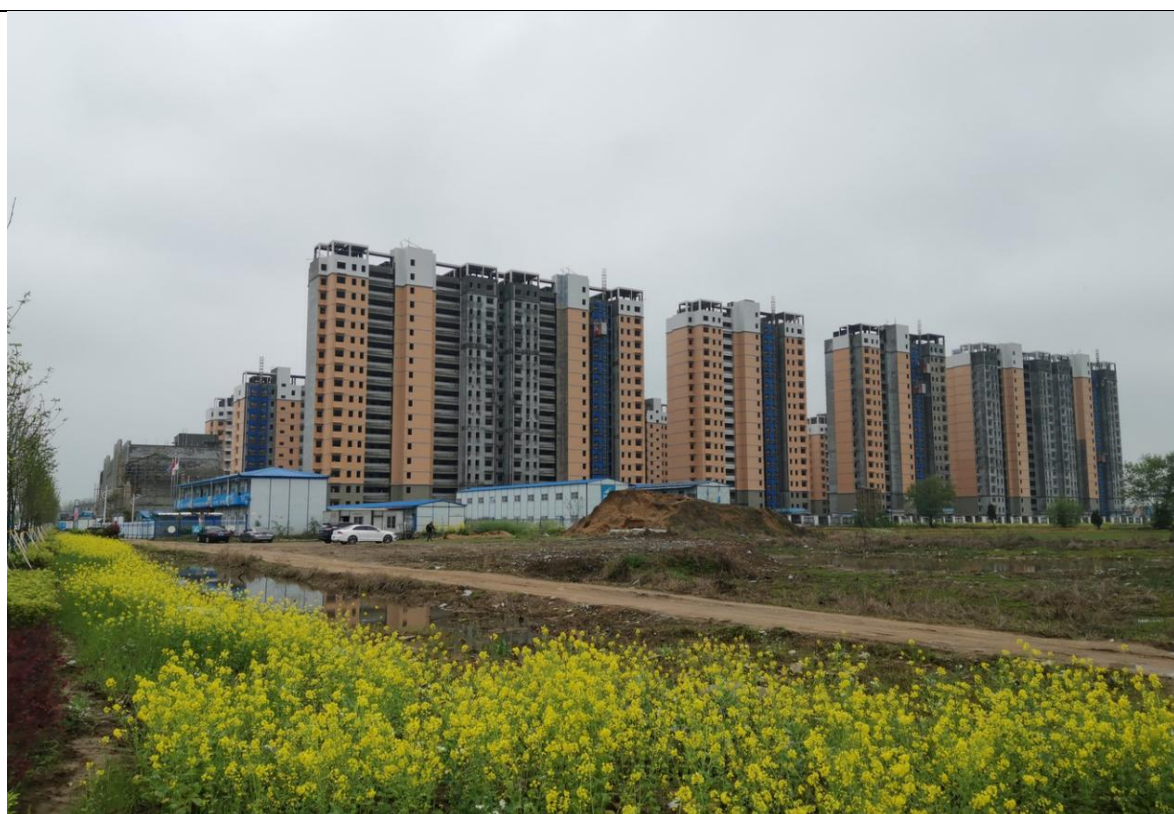
北侧 10#、11#、12#、13#住宅楼完成情况
