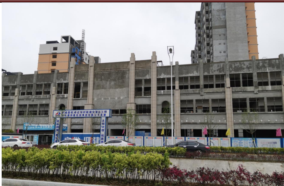
东侧 14#商业楼完成情况
