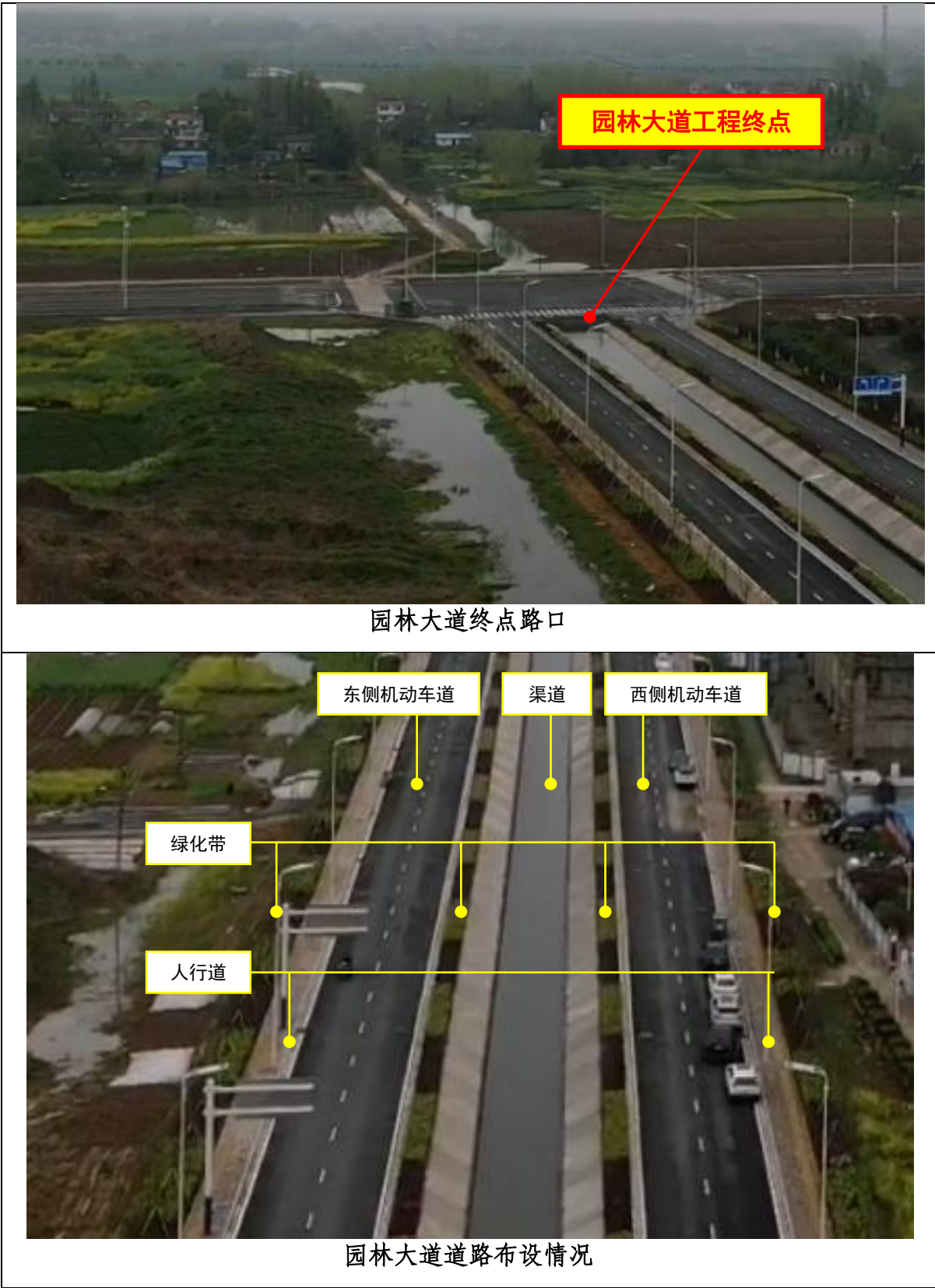
图 1.1-1 项目建设进展情况图片
