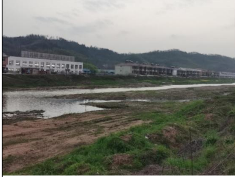
杨家皈拦水坝现状
