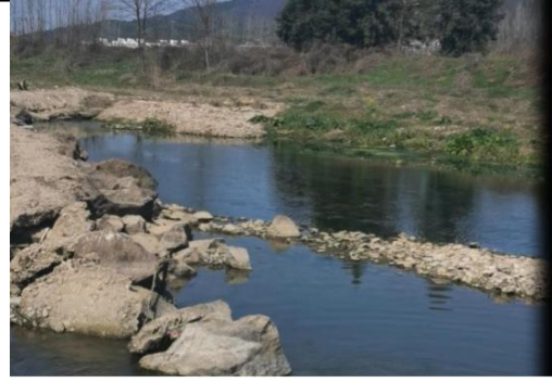
小湾拦水坝现状
