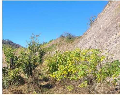
照片 3-4 +150m 台阶现状
