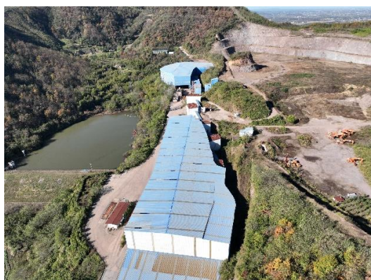
照片 3-7 南侧生产车间
