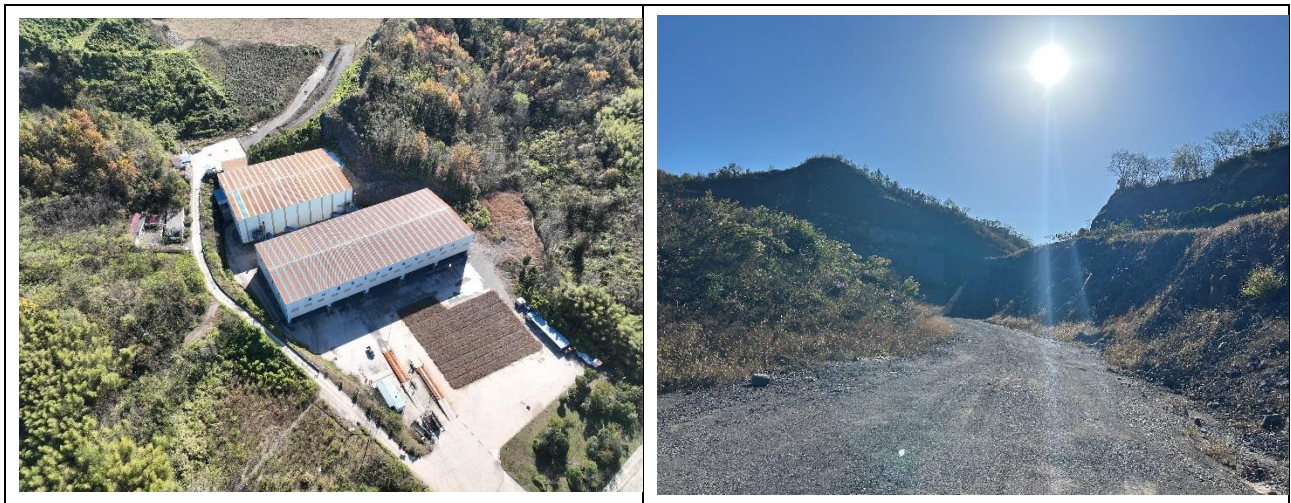
图 3-3 矿区道路现状图
