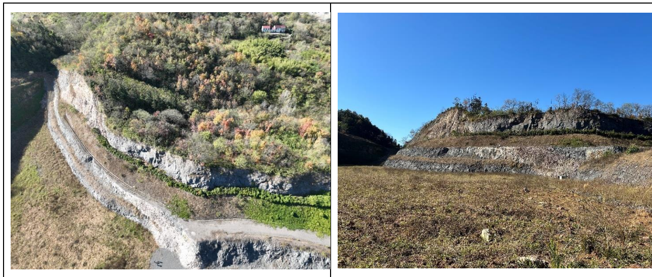
图 3-5 安全设施设计优化方案修复区现场图
