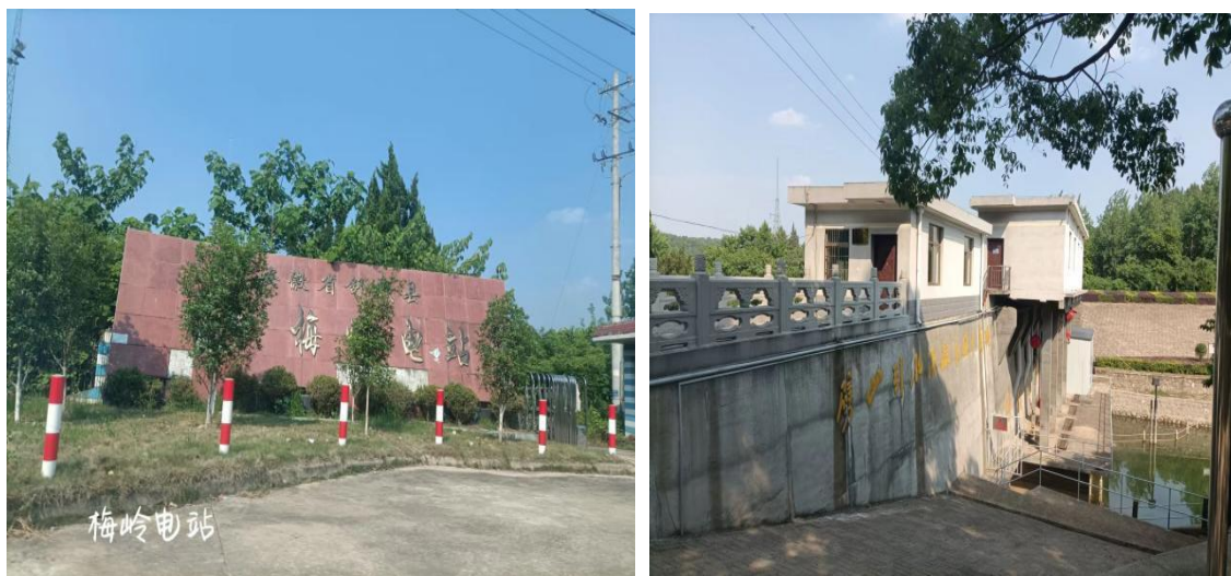
图 2.1-3 梅岭电站及梅岭进水闸现状图
