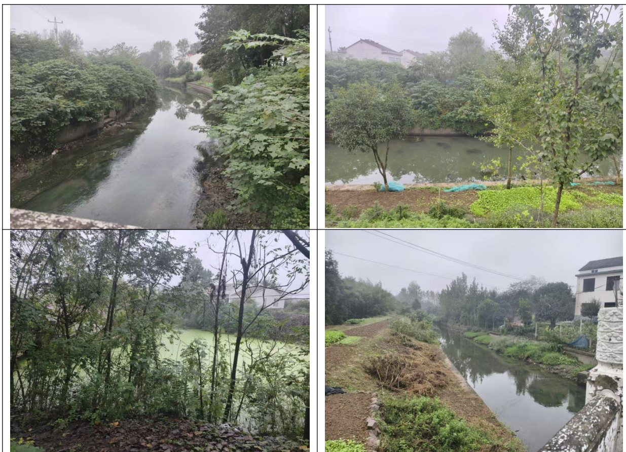
图 2-1 项目工程现状图
